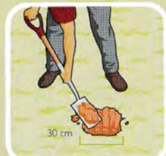
Löcher für die Zaunpfosten graben.
