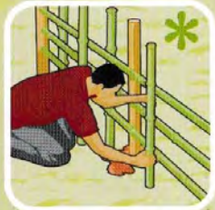
Längstreben zuschneiden und aufstellen.
